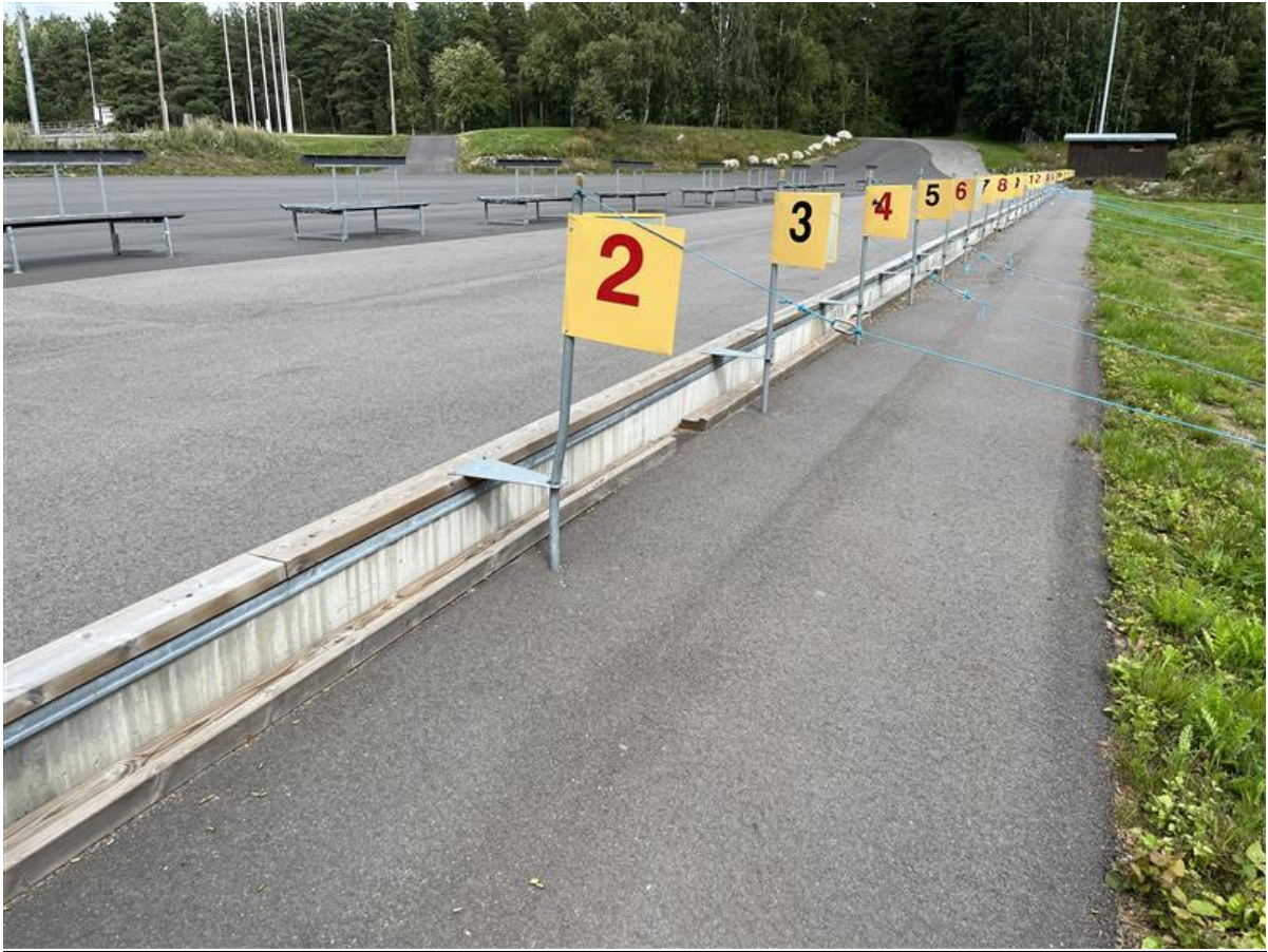
Kuva 3-2. Asfaltoitu alue ampumapaikalta.
