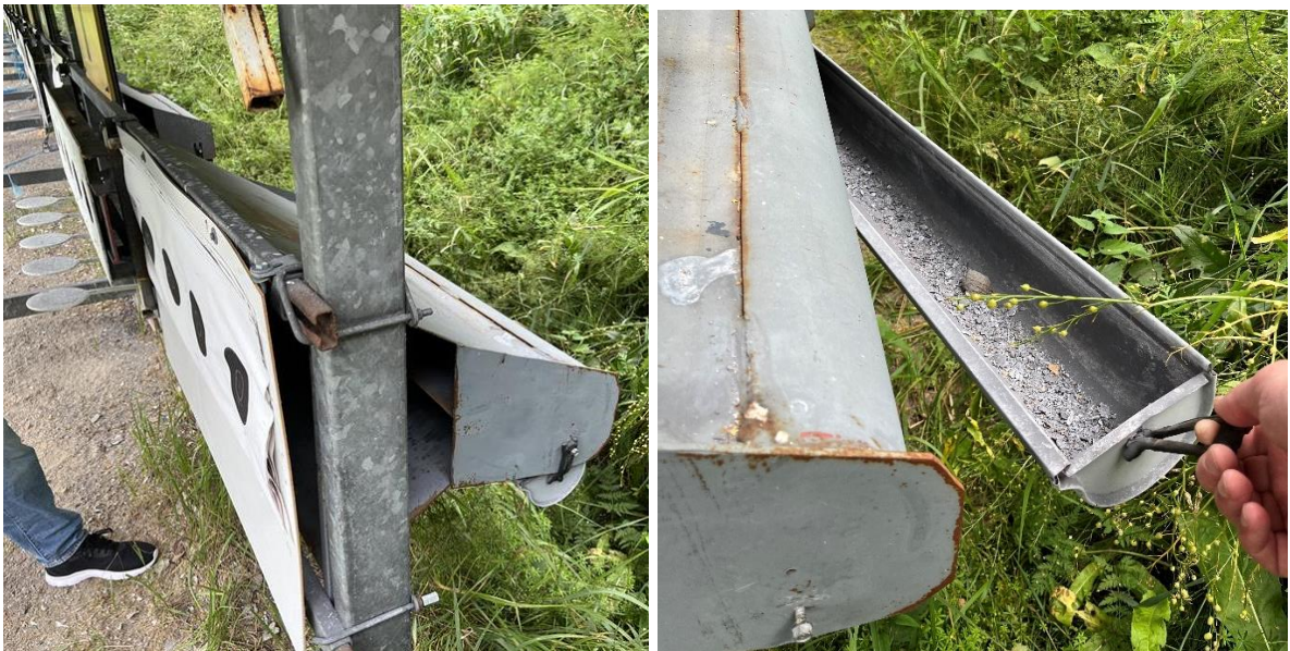
Kuva 3-3. Paperisten ampumataulujen luotien keräyskourut.
